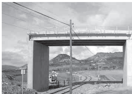
Paso elevado del Azud. Foto: Pepe Bescós
